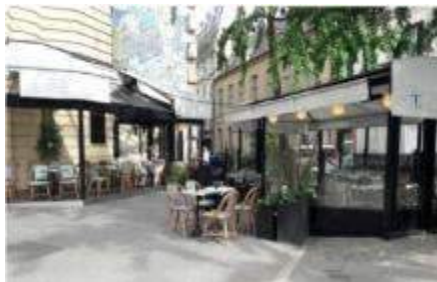
Terrasse, contre-terrasse et sa verrière sur l'espace public
