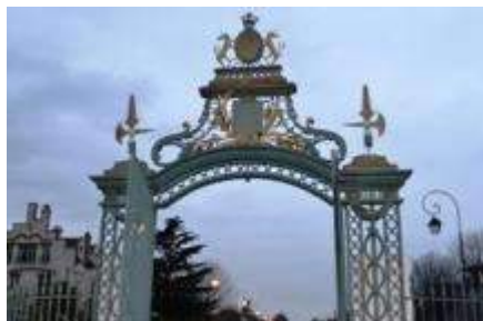
La grille du château à restaurer
