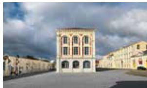
Saint-Étienne (42), Ancienne Manufacture nationale d'armes construite en 1803, aujourd'hui réhabilitée en Cité du Design (renouvellement parcellaire 1803 et 2004).
