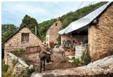
Ensemble fonctionnel à Argenton (La Fugère) : le fenil de l'entrepôt, dessous par sa base fenêtrée, donne sur l'aire à fouler et la « cabane ».
